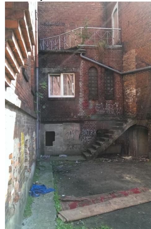
Fot. 24. Podwórze budynku przy ul. Pocztovej 7
