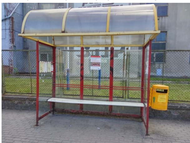
Rys. 22. Przystanek przy ul. Portowej 47
