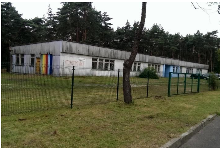
Rys. 43. Budynek przy ul. Zwycięstwa 17
