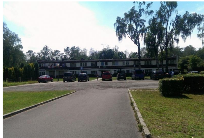
Rys. 68. Plac przy ul. Chemików wymagający zagospodarowania
