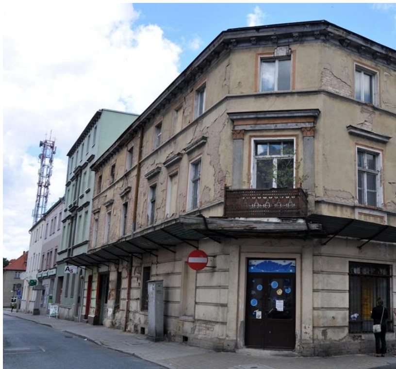
Rys. 57. Zniszczony budynek na skrzyżowaniu ul. Piramowicza i Anny
