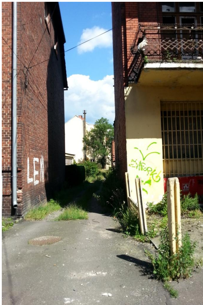
Rys. 60. Nietwardzona nawierzchnia drogi prowadzącej na podwórko przy ul. Pocztowej 4
