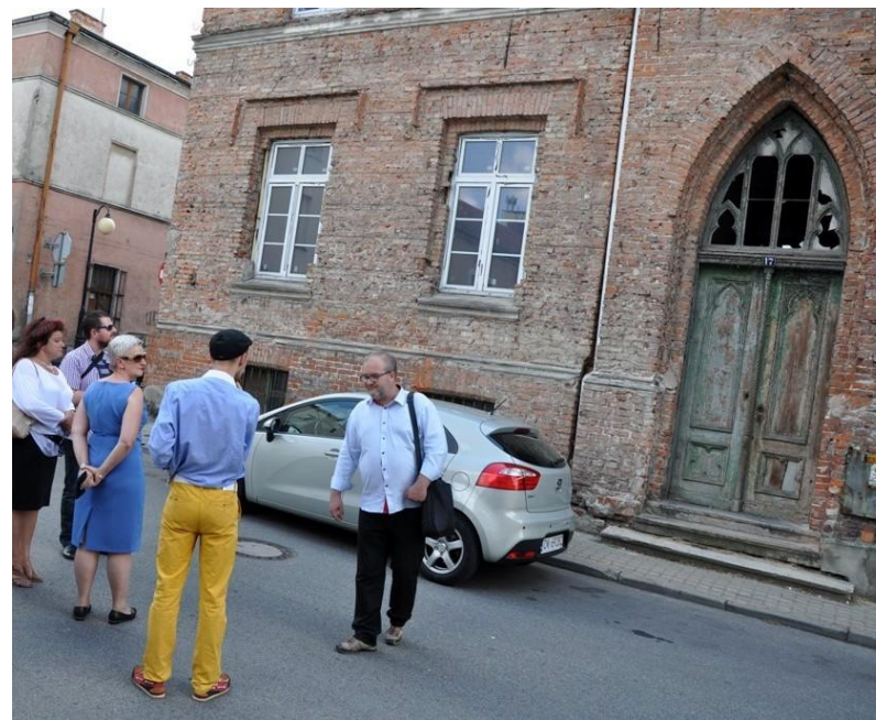
Rys. 56. Remontowany budynek przy ul. Piramowicza 17
